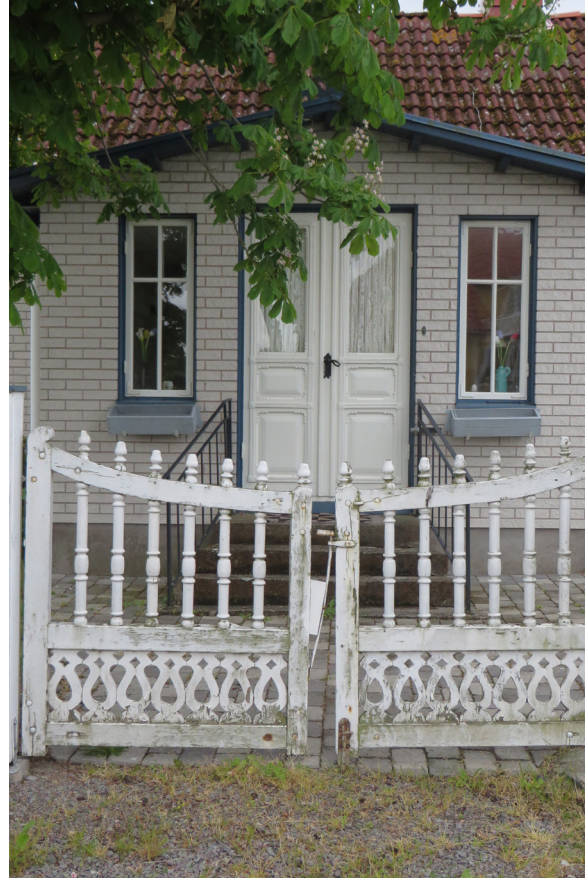
Dörr och grind till en av området gamla småstugor.
