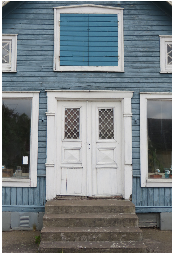
Ett av handelshusen, med typisk gavelstående placering. Många bevarade äldre detaljer, som dörr och panel.
