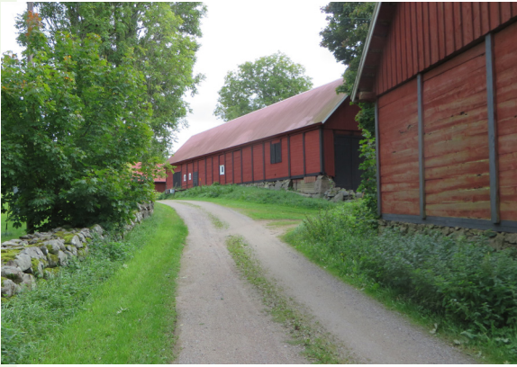
Bränderås, ekonomibyggnader i skiftesverk.
