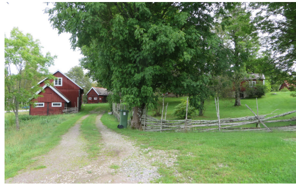
En av de äldre gårdarna mitt i byn Bränderås, med bevarad ladugård, uthus, trädgård med hamlade träd, gärdesgård och stenmurar.
