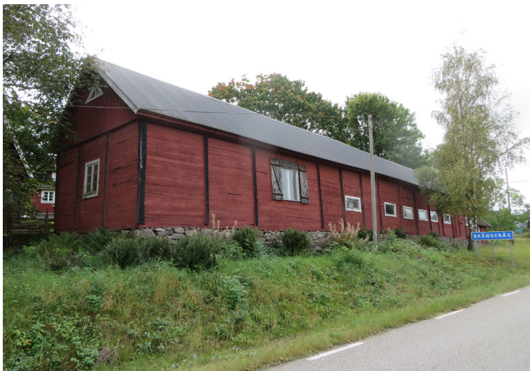
Bränderås, ekonomibyggnader i skiftesverk.
