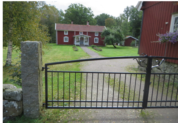
Hallasjö, gård med veranda med snickarglädje.
