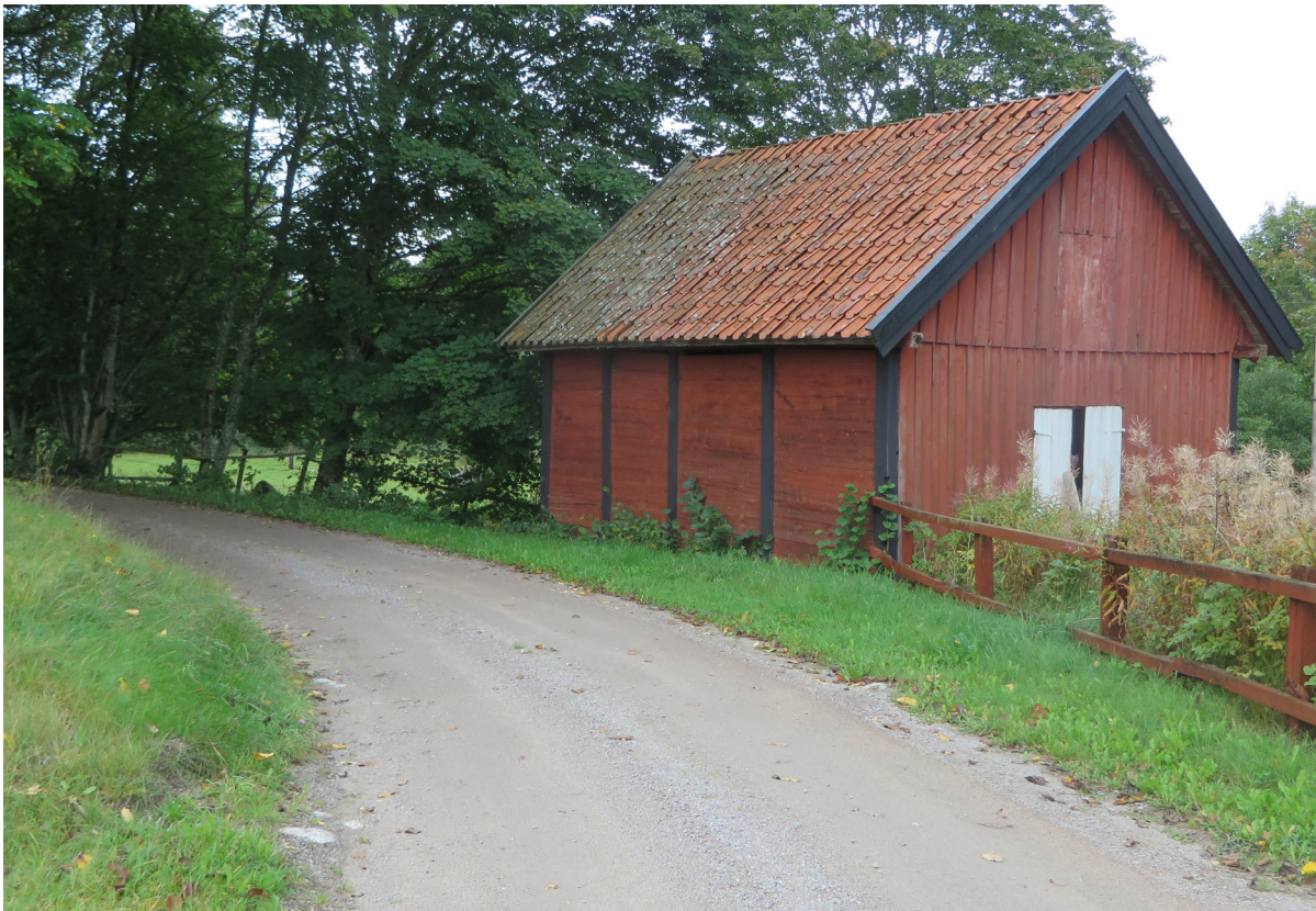
Ett av de äldre uthus som finns i Hallasjö by. Stommen är byggd i skiftesverk och på taket ligger pannor av lertegel.
