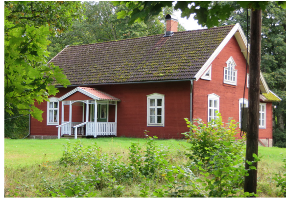
En av de välbevarade mangårdsbyggnaderna i byn Hallasjö.
