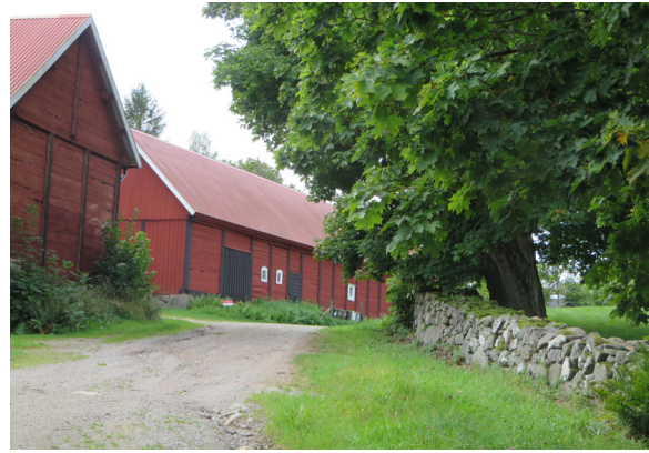
Bränderås, ekonomibyggnader i skiftesverk.
