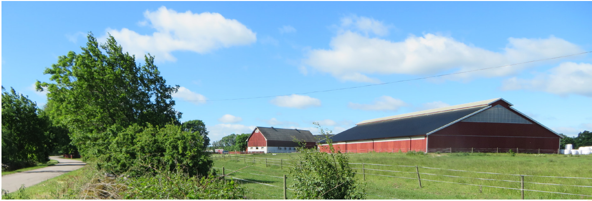
Den gamla gården centralt i Bröms har ladugårdar och ekonomibyggnader från olika tider, vilket visar på den långa kontinuiteten av jordbruksdrift. Den faluröda färgskalan håller samman miljön.
