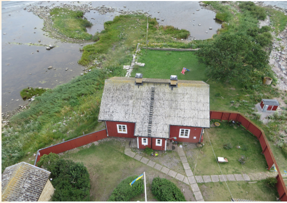
Den äldre fyrmästARBostaden mot söder. Till höger transformatorstationen.
