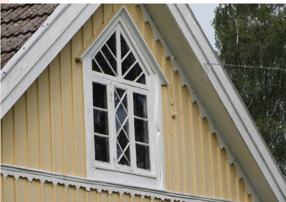
Ett unikt fönster och en gavel med Torsåspanel.
