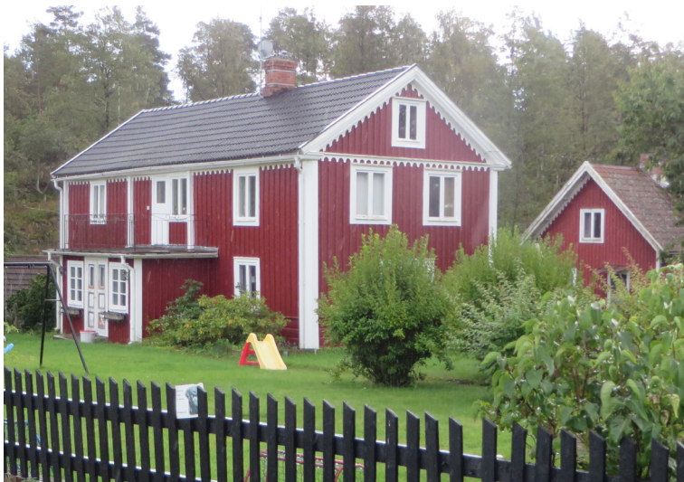
Mangårdsbyggnad, parstuga med delvis Torsåspanel.
